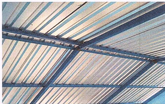
Foto 2: sustitución de estructura de soporte de madera por metal finalizado
