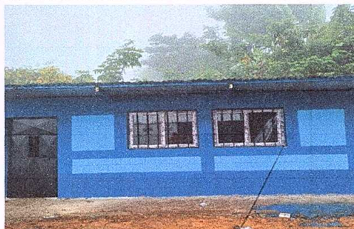
Foto 6: mantenimiento en cocina finalizado
