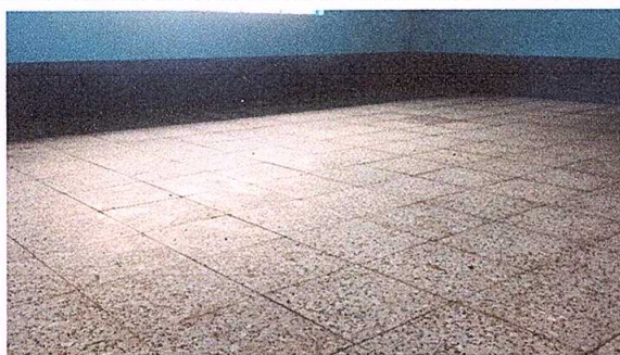
Foto 5: sustitución de piso por piso granito finalizado
