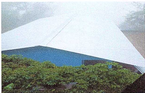
Foto 1: sustitución de techo finalizado
