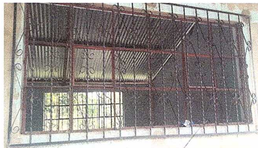
Foto 4: mantenimiento de ventanas
