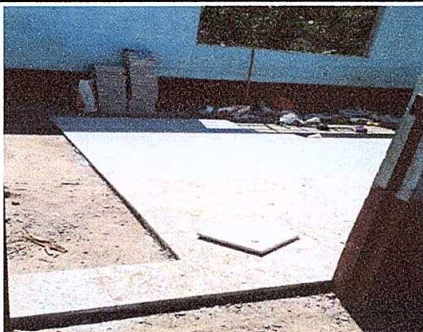
Foto 5: sustitución de piso por piso granito
