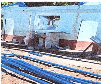
Foto 3: sustitución de puertas
