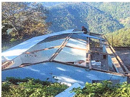
Foto1: desmontando el techo en las aulas
