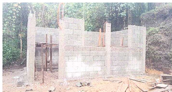
Foto 6: cocina en mantenimiento
