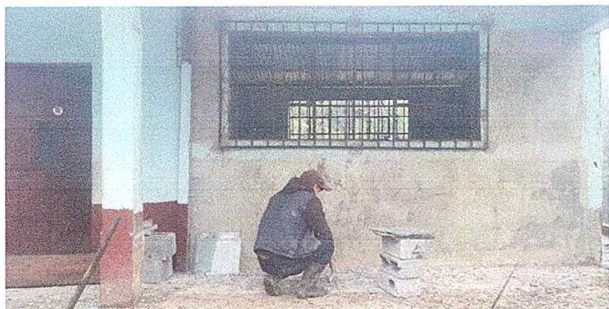
Foto 7: preparación de paredes para aplicar la pintura
