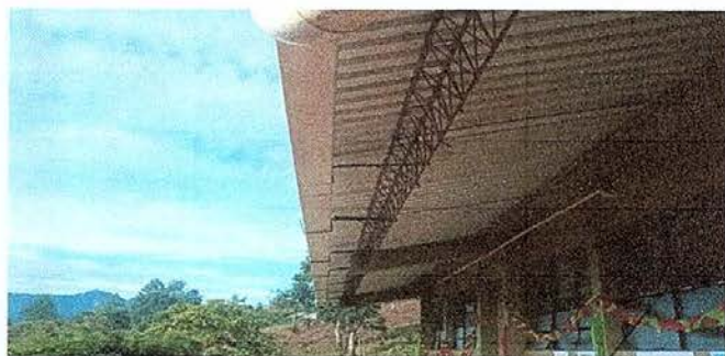
Foto 8: SUSTITUCION DE CANALES POR MALAS CONDICIONES
