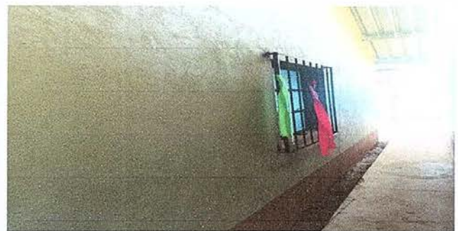
Foto 4: SUSTITUCIÓN DE VENTANAS
