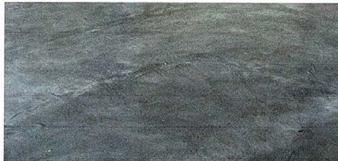
Foto 7: SUSTITUCION DE PISO POR MAL ESTADO
