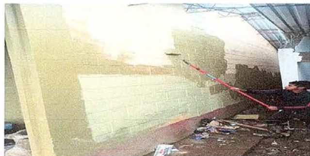
Foto 9: PINTURA EN MUROS EXTERIORES E INTERIORES
