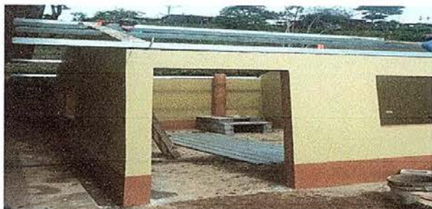
Foto1: TECHO, ESTRUCTURA DE SOPORTE, TECHO Y PUERTA EN MALAS CONDICIONES
