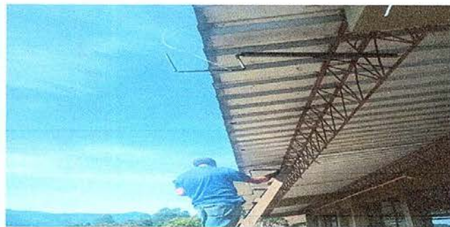
Foto 8: SUSTITUCION DE CANALES POR MALAS CONDICIONES
