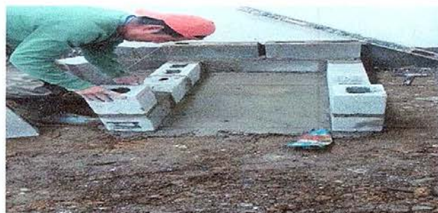
Foto 6: SUSTITUCIÓN DE PLANCHA ARTESANAL COMPLETA
