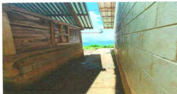
Foto 4: SUSTITUCIÓN DE VENTANAS
