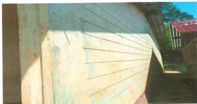
Foto 9: PINTURA EN MUROS EXTERIORES E INTERIORES
