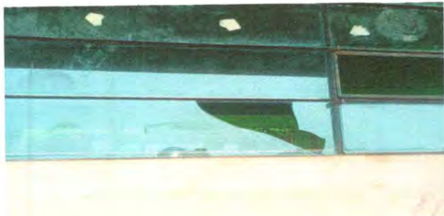
Foto 5: SUSTITUCIÓN DE VIDRIOS POR MAL ESTADO
