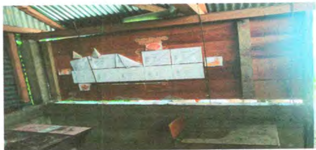
Foto 11: SUSTITUCIÓN DE PARED DE MADERA POR BLOCK
