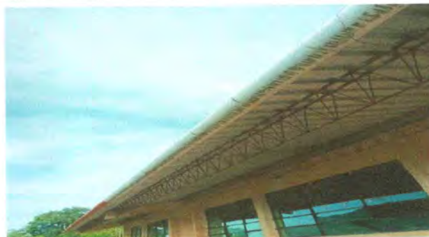
Foto 8: SUSTITUCION DE CANALES POR MALAS CONDICIONES
