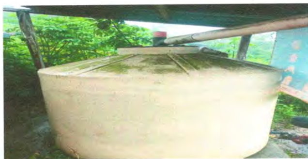
Foto 10: SUSTITUCION DE DEPOSITO DE AGUA POR MAL ESTADO
