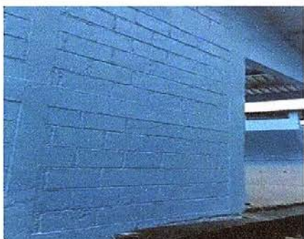
Foto 9: pintura en muros exteriores e interiores.
