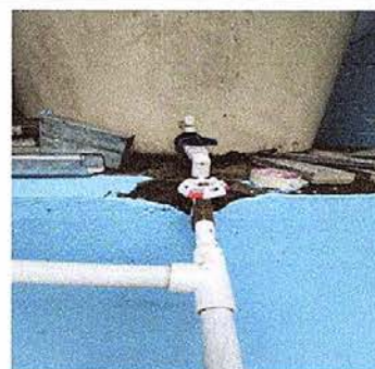
Foto 22: sustitución llave de globo
