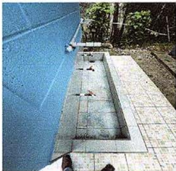
Foto 13: sustitución de llave de chorro.
