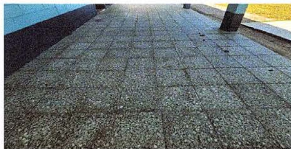
Foto 14: reparación de planchas de concreto de patio.
