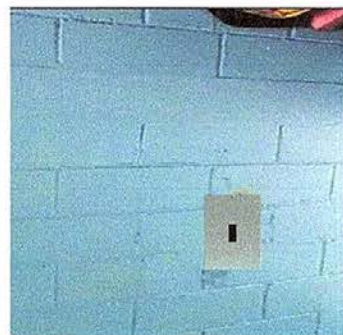
Foto 16: sustitución de tablero de flipones.
