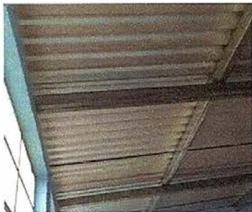
Foto 3: sustitución de elementos de fijación.
