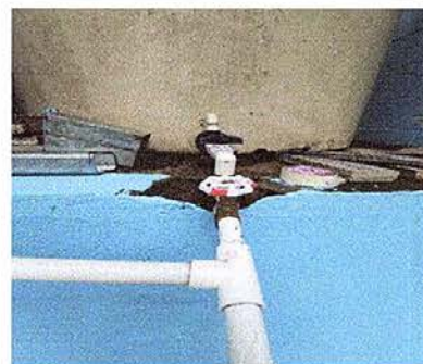
Foto 12: sustitución de llave de globo.
