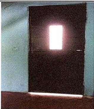
Foto 19: fabricación e instalación de puertas de metal en módulos (cocina)
