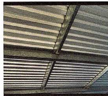
Foto 4: sustitución de estructura de soporte de metal por metal.
