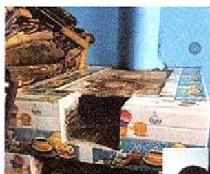
Foto 23: Sustitución de azulejo en plancha artesanal
