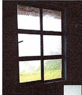
Foto 7: sustitución de ventanas de madera por metal mas vidrio.
