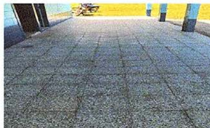
Foto 8: sustitución de piso de torta de concreto.
