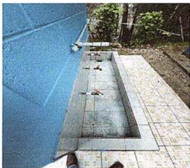
Foto 11: sustitución de tubería línea principal.
