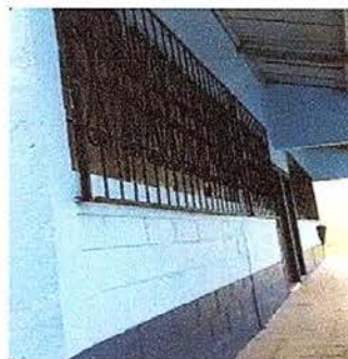
Foto 20: fabricación de balcones de hierro en ventana
