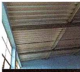
Foto 1: sustitución de lámina por lámina troquelada.
