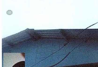
Foto 2: sustitución de capote de lámina troquelada para lámina troquelada.
