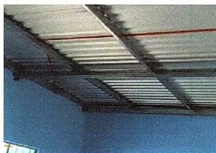
Foto 18: sustitución de conducto eléctrico
