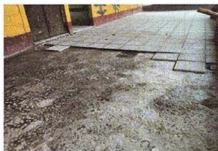
Foto 8: sustitución de piso de torta de concreto.
