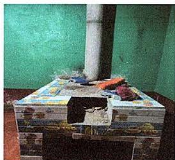
Foto 21: sustitución de chimenea de concreto
