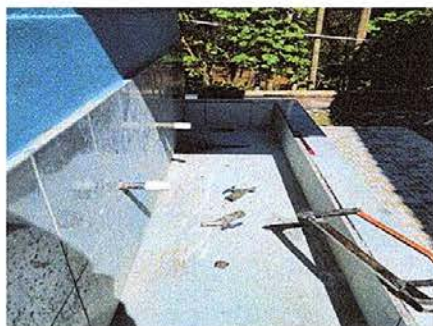
Foto 11: sustitución de tubería línea principal.
