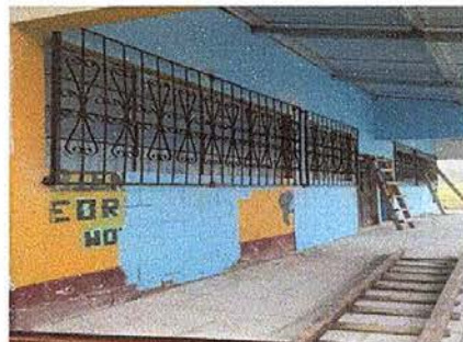
Foto 20: fabricación de balcones de hierro en ventana
