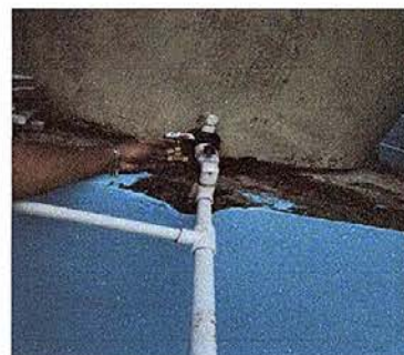
Foto 12: sustitución de llave de globo.
