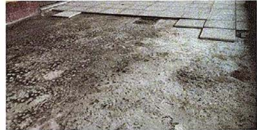
Foto 14: reparación de planchas de concreto de patio.
