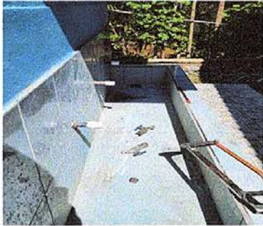
Foto 13: sustitución de llave de chorro.
