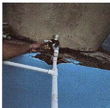
Foto 22: sustitución llave de globo
