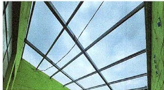
Foto 18: sustitución de conducto eléctrico
