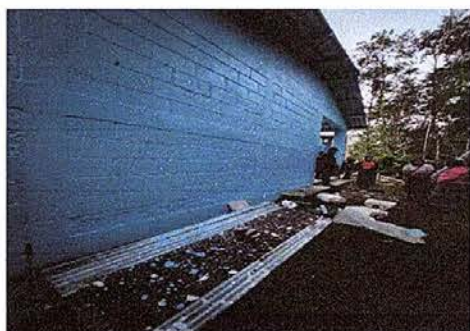
Foto 9: pintura en muros exteriores e interiores.
