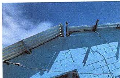
Foto 2: sustitución de capote de lámina troquelada para lámina troquelada.
