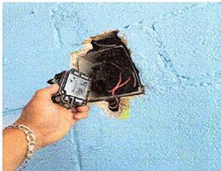
Foto 15: sustitución de flipones.
