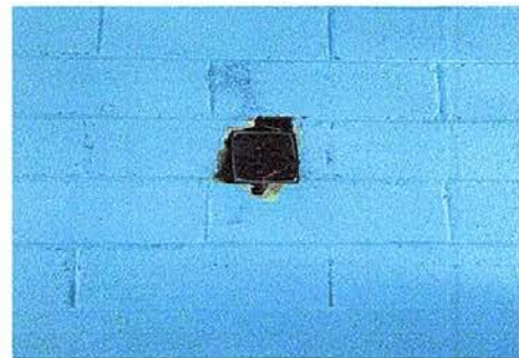
Foto 16: sustitución de tablero de flipones.
