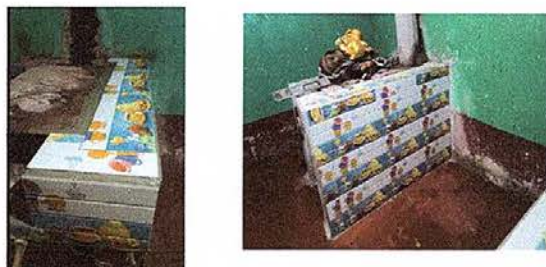
Foto 23: Sustitución de azulejo en plancha artesanal
