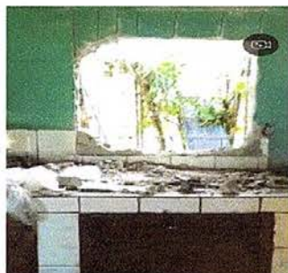
Foto 7: sustitución de ventanas de madera por metal mas vidrio.
