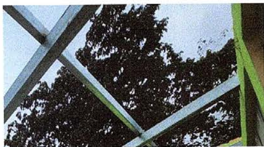
Foto 3: sustitución de elementos de fijación.
