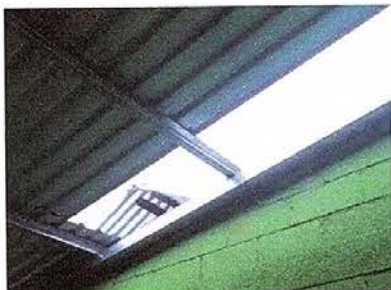
Foto 1: sustitución de lámina por lámina troquelada.
