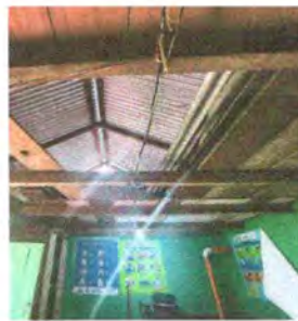
Foto 18: sustitución de conducto eléctrico
