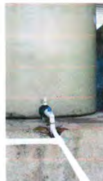
Foto 22: sustitución llave de globo
