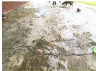
Foto 14: reparación de planchas de concreto de patio.
