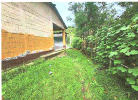
Foto 9: pintura en muros exteriores e interiores.
