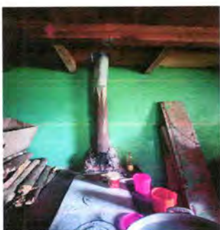
Foto 21: sustitución de chimenea de concreto
