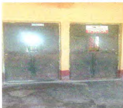
Foto 5: Mantenimiento de estructura de puertas de modulos (lijado y aplicación de pintura)
