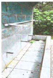
Foto 13: sustitución de llave de chorro.
