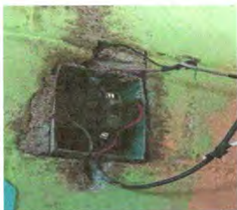
Foto 15: sustitución de flipones.
