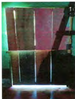
Foto 19: fabricación e instalación de puertas de metal en módulos (cocina)
