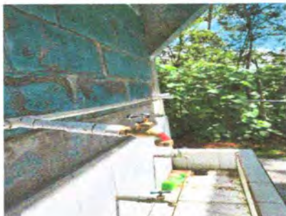
Foto 11: sustitución de tubería línea principal.
