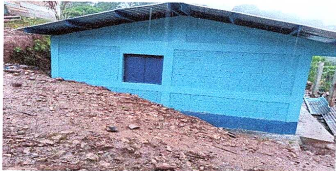
Foto1: Sustitución de paredes de madera por block
