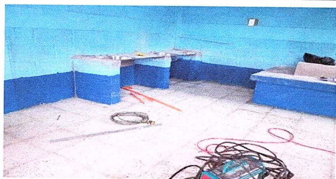
Foto 3: Reparación de piso de torta de concreto
