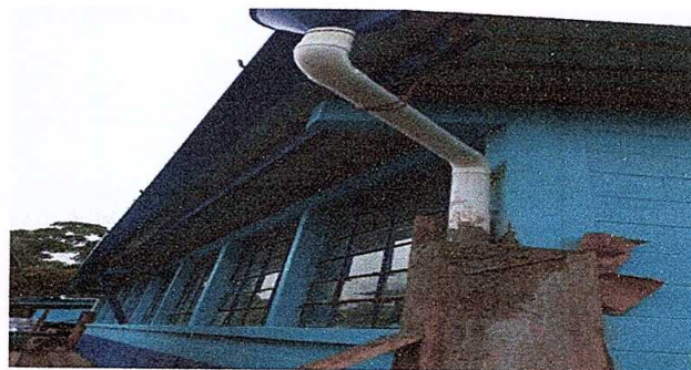
Foto 6: Reparacion de bajada de agua pluvial, tubo PVC 3"
