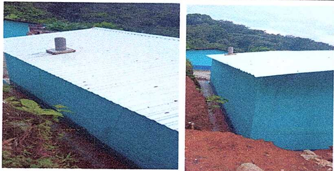
Foto 5: Sustitución de lamina, por lamina troquelada calibre 26
