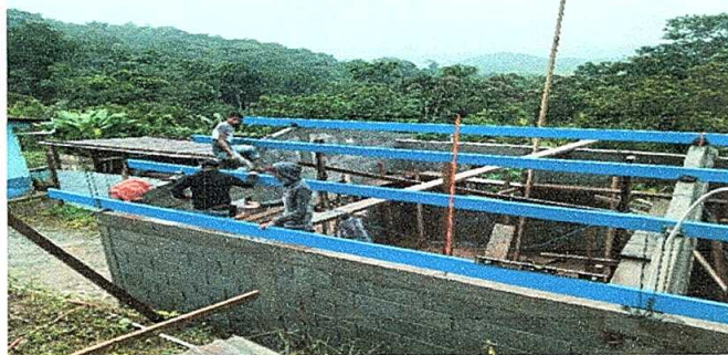
Foto 5: Sustitución de lamina, por lamina troquelada calibre 26
