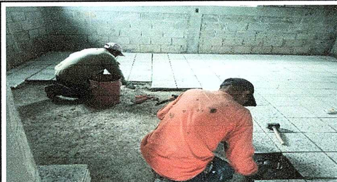
Foto 3: Reparación de piso de torta de concreto
