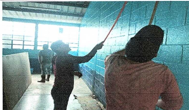
Foto 4: Pintura en muros exteriores e interiores.
