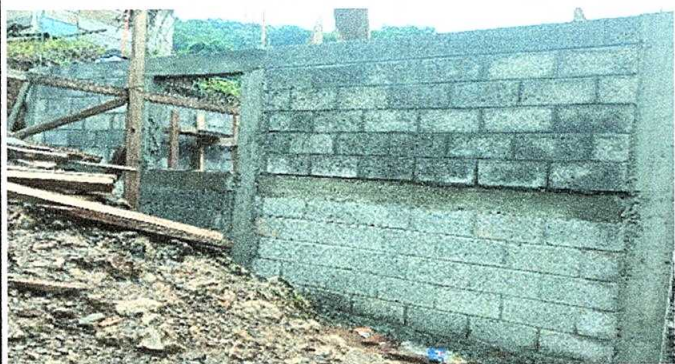
Foto1: Sustitución de paredes de madera por block
