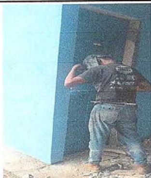
Foto 3: Sustitución de puertas en servicios sanitarios
