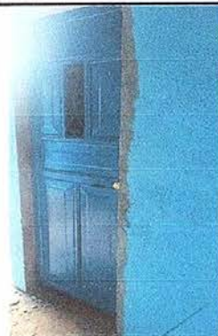
Foto 2: Mejoramiento de baño
