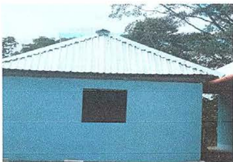
Foto 5: Sustitución paredes de madera por block
