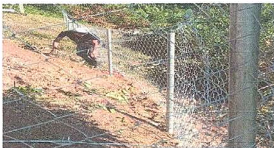
Foto 3: Sustitución de Tubo hg y malla galvanizada
