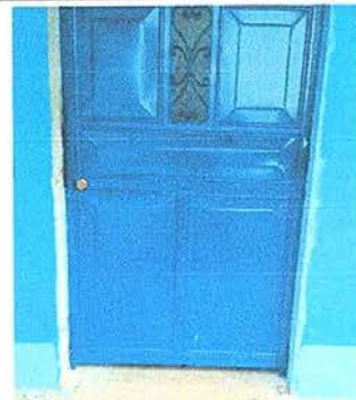
Foto 2: Mejoramiento de puertas de madera de 2 mts. x 1 mt.
