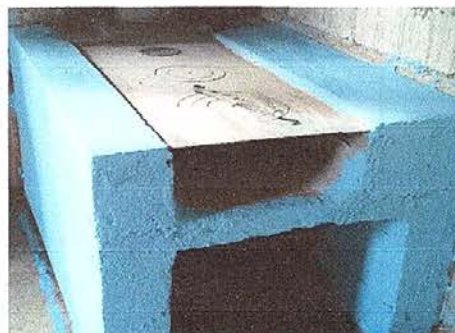
Foto 6: Sustitución de plancha de metal de 3 hornillas
