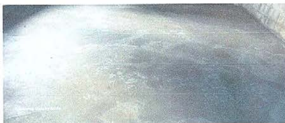
Foto 5: Mejoramiento de piso de concreto
