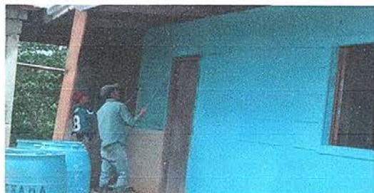
Foto 1: Aplicación de pintura en exterior e interior
