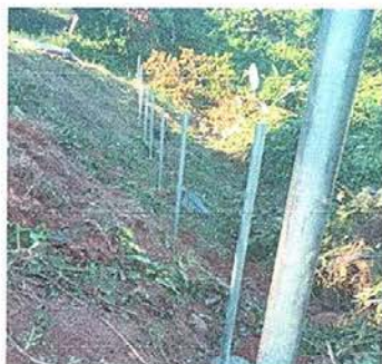
Foto 3: Sustitución de Tubo hg y malla galvanizada
