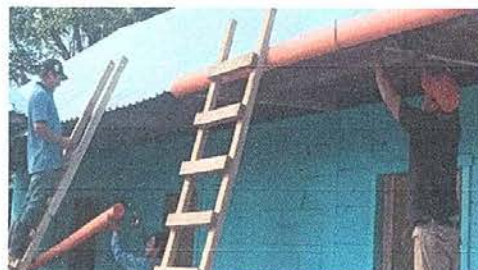
Foto 6: Sustitución de canales de agua pluvial de PVC
