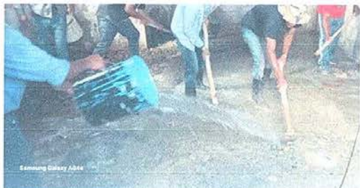
Foto 5: Mejoramiento de piso de concreto
