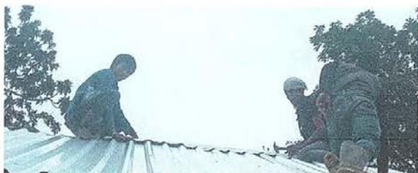
Foto 1: sustitución de capote de lamina, para lamina troquelada 1.5mts.
