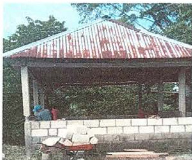
Foto 5: Sustitución paredes de madera por block
