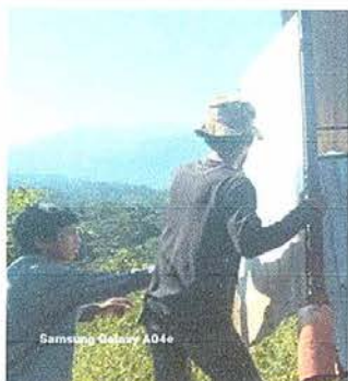
Foto 3:Sustitución de puertas en servicios sanitarios
