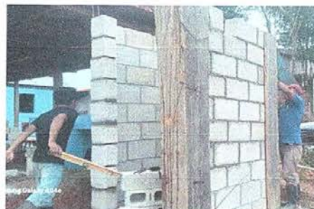
Foto 2: Mejoramiento de baño
