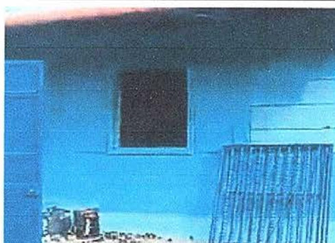
Foto 4: Mejoramiento de Ventanas 1.5 mts. x 1mt.
