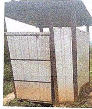
Foto 2: Mejoramiento de baño
