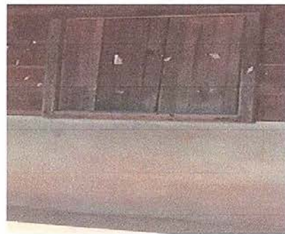
Foto 4: Mejoramiento de Ventanas 1.5 mts. x 1mt.
