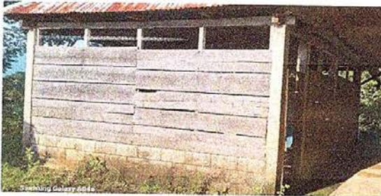
Foto 5: Sustitución paredes de madera por block
