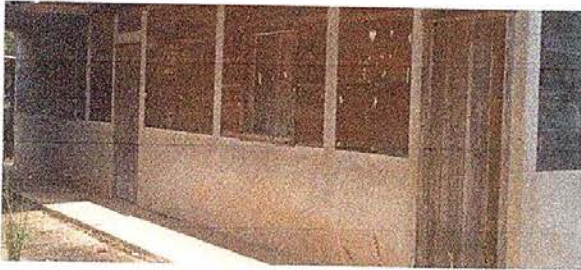
Foto 1: Aplicación de pintura en exterior e interior
