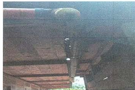
Foto 6: Sustitución de canales de agua pluvial de PVC
