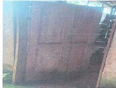
Foto 2: Mejoramiento de puertas de madera de 2 mts. x 1 mt.
