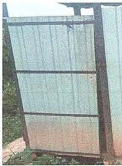
Foto 3: Sustitución de puertas en servicios sanitarios
