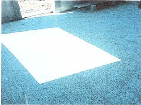
Foto No. 7: Sustitución de piso de torta de concreto por piso de granito.
