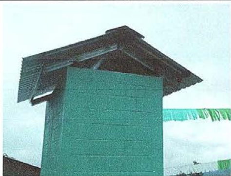
Foto No. 1: Sustitución de lámina de sanitarios en malas condiciones.
