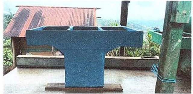
Foto No. 8: Sustitución de pila por nueva, ya que la existente se encuentra deteriorada.
