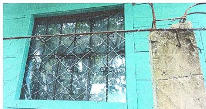
Foto No. 4: Sustitución de ventanas de madera por metal.
