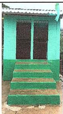
Foto No. 3: Sustitución de dos puertas de sanitarios de madera por metal.
