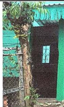
Foto No. 2: Sustitución de puerta de madera por metal.
