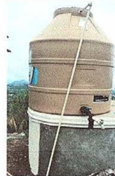
Foto No. 12: Sustitución de depósito de agua.
