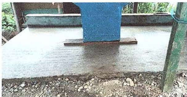
Foto No. 5: Mejoramiento de piso de concreto.
