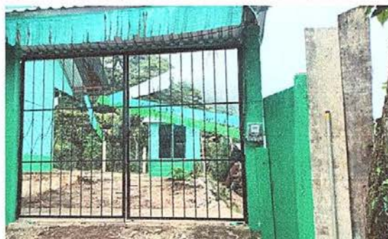
Foto No. 6: Sustitución de portón de madera por metal.
