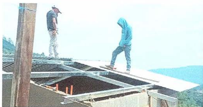
Foto No. 13: Sustitución de techo de lámina de cocina en malas condiciones
