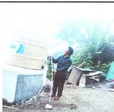
Foto No. 12: Sustitución de depósito de agua.
