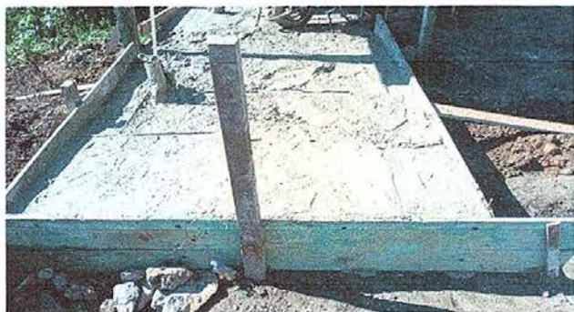
Foto No. 5: Mejoramiento de piso de concreto.
