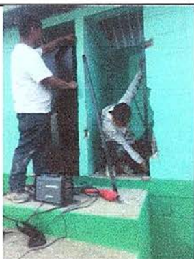
Foto No. 3: Sustitución de dos puertas de sanitarios de madera por metal.
