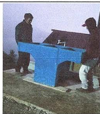
Foto No. 8: Sustitución de pila por nueva, ya que la existente se encuentra deteriorada.
