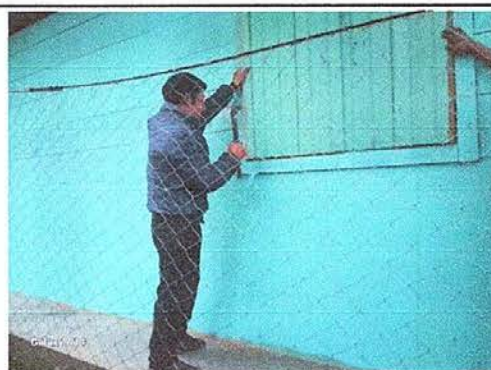
Foto No. 4: Sustitución de ventanas de madera por metal.
