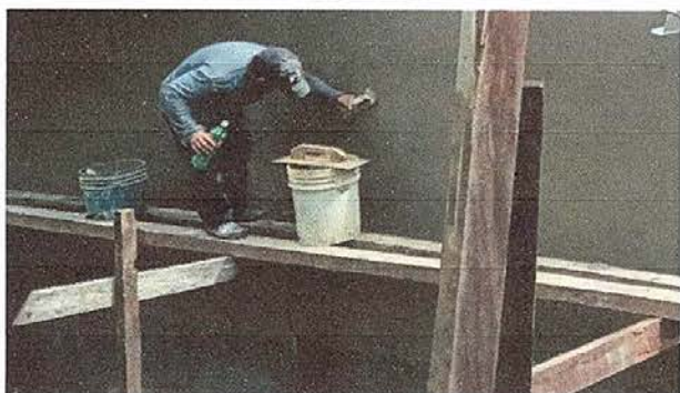
Foto No. 9: Repello de paredes.
