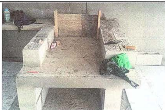
Foto No. 10: Reparación de plancha, chimenea, entre otros para mejorar los ambientes de la cocina.
