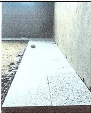
Foto No. 7: Sustitución de piso de torta de concreto por piso de granito.
