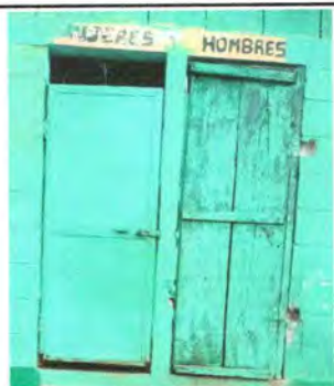
Foto No. 3: Sustrucción de dos puertas de sanitarios de madera por metal.
