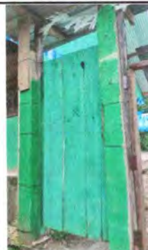
Foto No. 2: Sustrucción de puerta de madera por metal.
