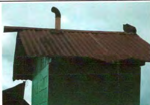
Foto No. 1: Sustrucción de lámina de sanitarios en malas condiciones.
