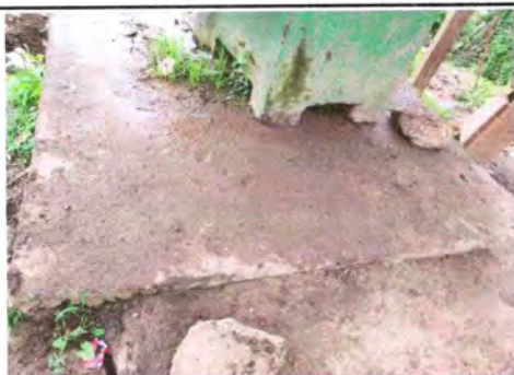
Foto No. 5: Mejoramiento de piso de concreto.
