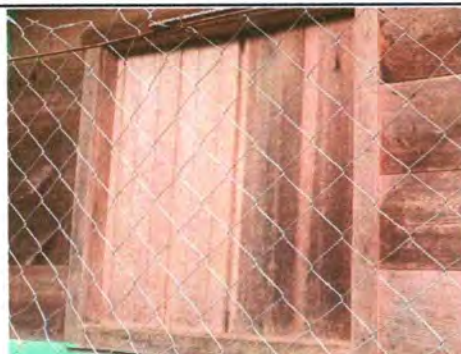
Foto No. 4: Sustrucción de ventanas de madera por metal.
