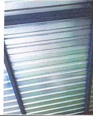
Foto 2: Mantenimiento a estructura de soporte
