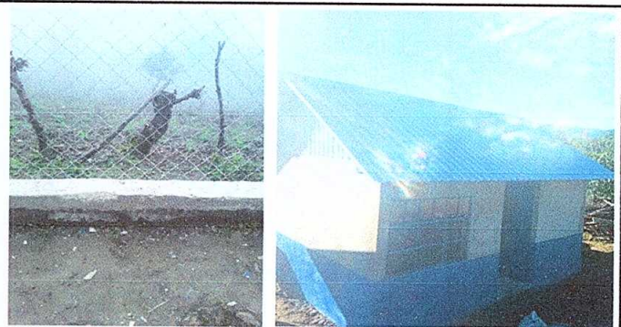
Foto 6: Sustrución de muro perimetral que se encuentra en mal estado y sustrución de pared de madera por block
