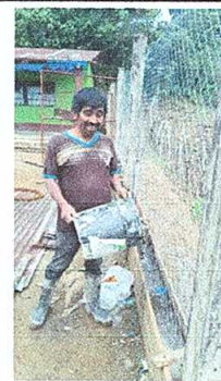
Foto 6: Sustitución de muro perimetral que se encuentra en mal estado y sustitución de pared de madera por block
