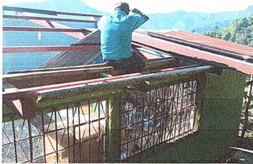
Foto 1: Sustitución de lámina en malas condiciones por lámina troquelada Aluzinc calibre 26
