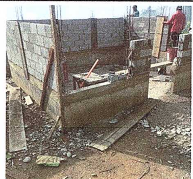
Foto 6: Sustitución de muro perimetral que se encuentra en mal estado y sustitución de pared de madera por block
