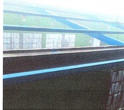
Foto 2: Mantenimiento a estructura de soporte
