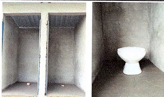
Foto 7: sustitución de paredes de madera por block e inodoros
