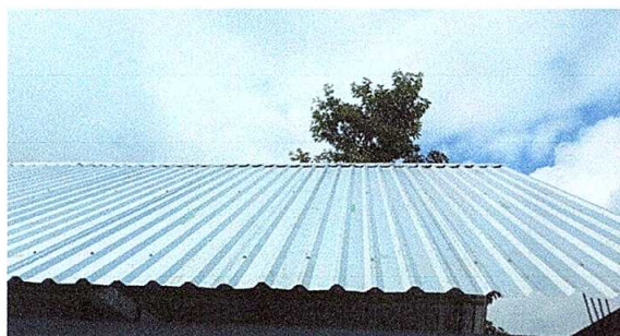
Foto 1: sustitución de lámina, por lámina troquelada (cocina)
