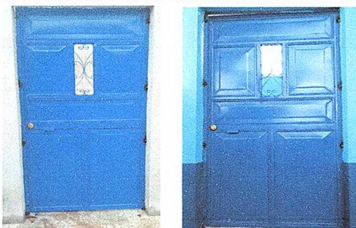
Foto 3: sustitución de puertas
