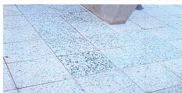
Foto 4: sustitución de piso de torta de concreto
