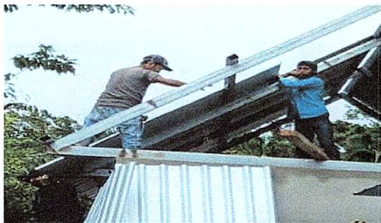
Foto 1: sustitución de lámina, por lámina troquelada (cocina)
