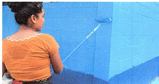
Foto 6: pintura en muros interiores y exteriores
