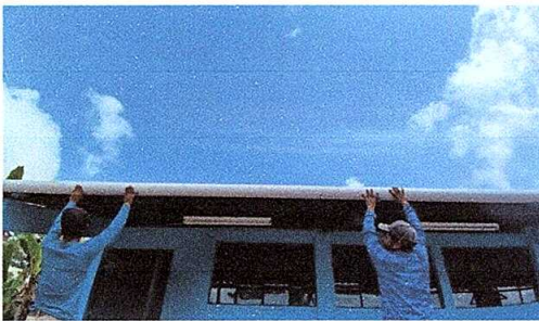
Foto 5: sustitución de canal de pvc
