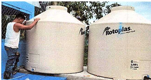
Foto 8: sustitución de depósito de agua
