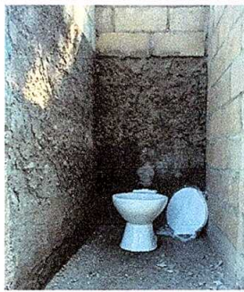
Foto 7: sustitución de paredes de madera por block e inodoros
