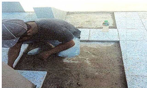
Foto 4: sustitución de piso de torta de concreto
