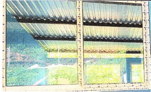
Foto 2: Finalización de instalación de ventanas.
