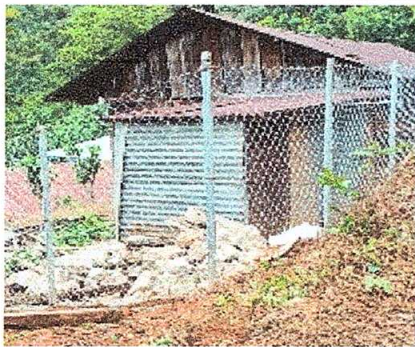
Foto 5: Reparación de muro perimetral finalizado.
