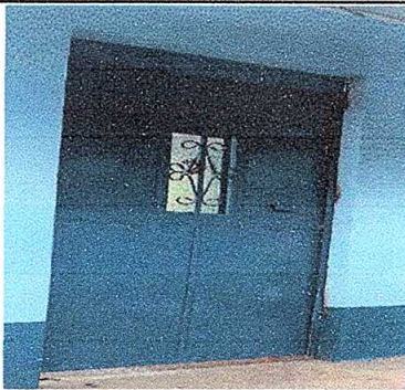
Foto 3: Sustitución de puerta finalizada.
