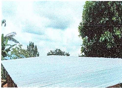
Foto1: Finalización de instalación de láminas troqueladas.
