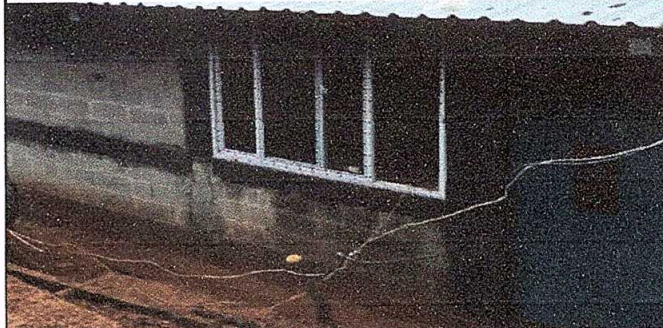
Foto 2: Sustitución de puertas y ventanas de madera por puertas de metal y ventanas de metal
