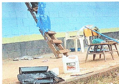
Foto 4: Sustitución de pintura.
