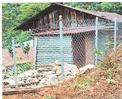
Foto 5: Reparación de muro perimetral en proceso
