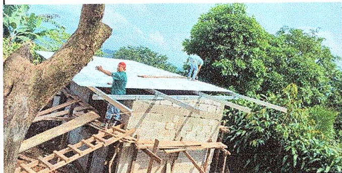
Foto1: Sustitución de láminas viejas por laminas nuevas troqueladas
