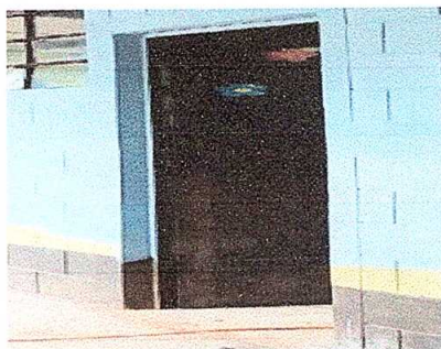
Foto 3: Sustitución de puerta.
