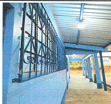
Foto 4: Sustitución de estructura de metal de ventanas de 2 metros de largo x 1,75 de ancho
