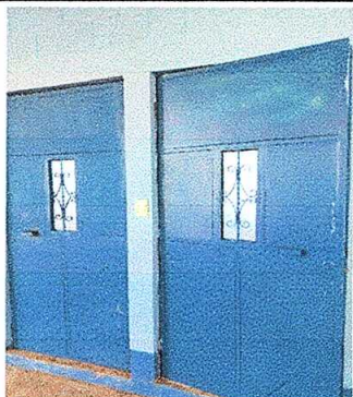
Foto 3: Sustitucion de puertas
