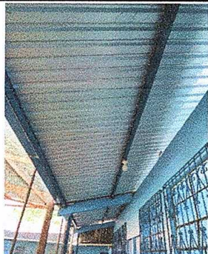
Foto1: sustitución de lámina, por lámina troquelada Aluzinc 16 pie calibre 26, costaneras.
