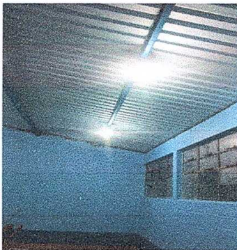
Foto 7: Reparación de sistema eléctrico
