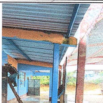
Foto 2: Sustitucion de canaletas de pvc por metal
