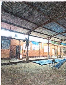
Foto1: sustitución de lámina, por lámina troquelada Aluzinc 16 pie calibre 26, costaneras.
