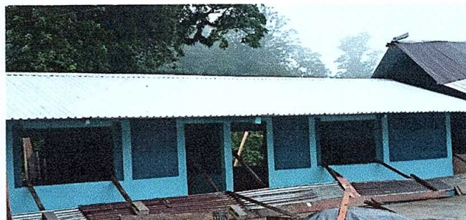
Foto No. 6: Sustrucción pared de tabla por block.
