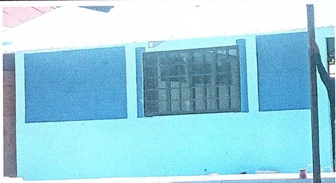
Foto No. 3: Sustrucción de ventanas de madera por metal mas vidrio.
