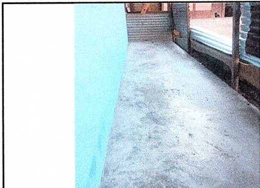
Foto No. 7: Reparación de piso de concreto.
