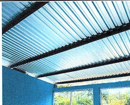
Foto No. 2: Sustrucción de estructura de soporte de madera por metal.
