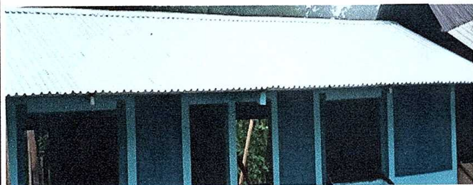
Foto No. 1: Sustrucción de lámina por lámina troquelada aluzinc calibre 26.
