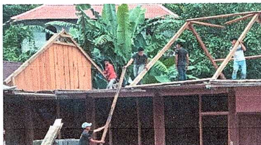
Foto No. 2: Sustitución de estructura de soporte de madera por metal.
