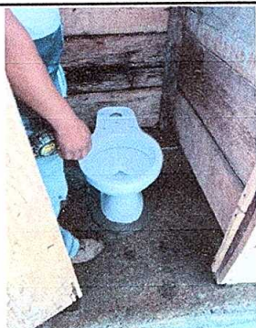
Foto No. 5: Sustitución de inodoro.
