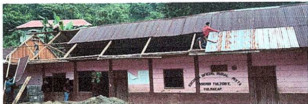
Foto No. 1: Sustitución de lámina por lámina troquelada aluzinc calibre 26.
