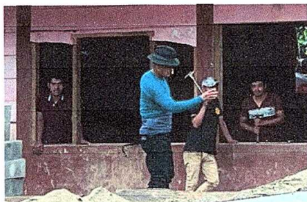
Foto No. 3: Sustitución de ventanas de madera por metal mas vidrio.
