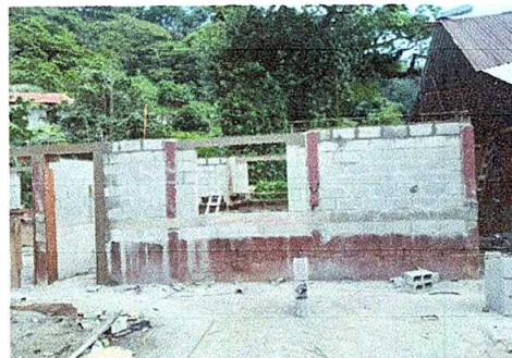
Foto No. 6: Sustitución pared de tabla por block.
