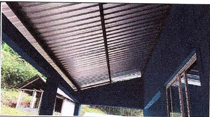
Foto 9: Sustitución de lámina en el techo finalizada
