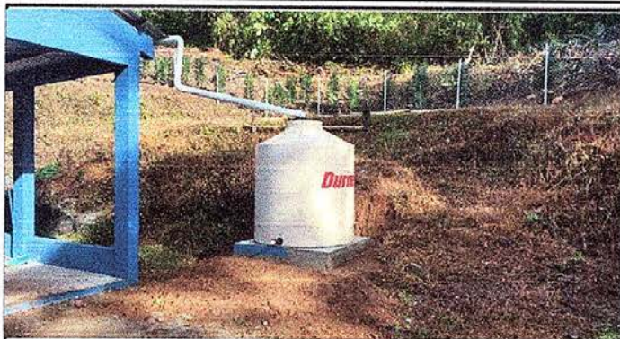
Foto 1: Instalación de depósito de agua finalizada
