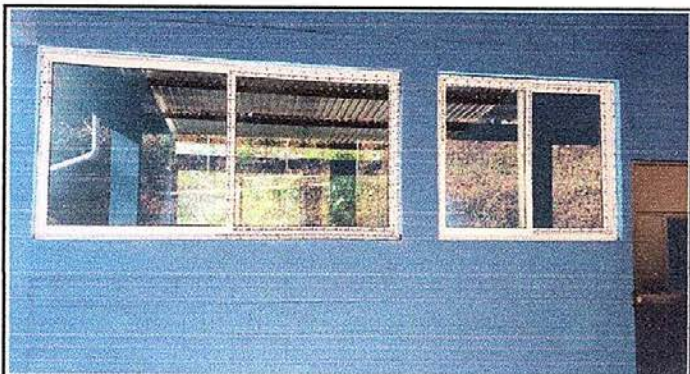
Foto 3: Instalación de ventanas del aula 1 finalizada
