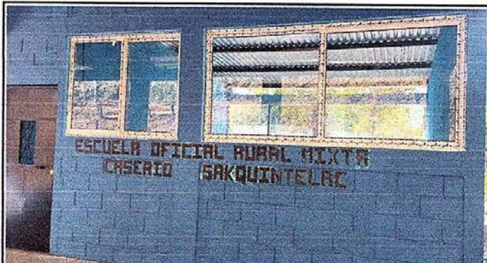
Foto 4: Instalación de ventanas de aula 2 finalizada
