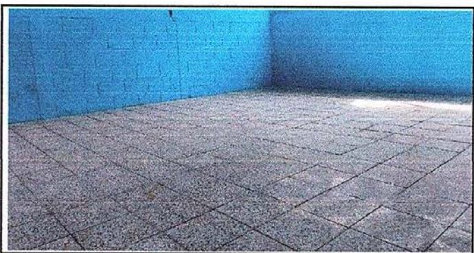
Foto 5: sustitución de piso en las aulas finalizada
