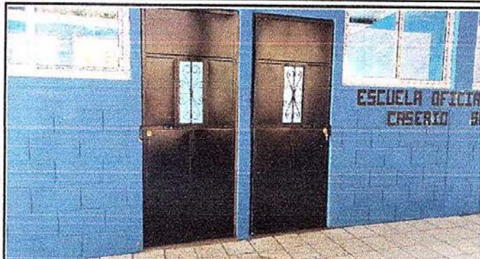
Foto 2: Instalación de puertas nuevas finalizada
