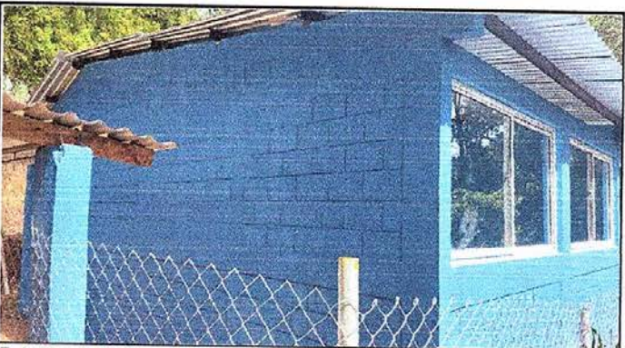
Foto 10: pintura en muros exteriores finalizada
