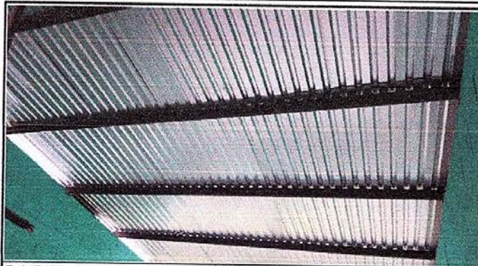
Foto 7: Finalización de mantenimiento a estructura de techo
