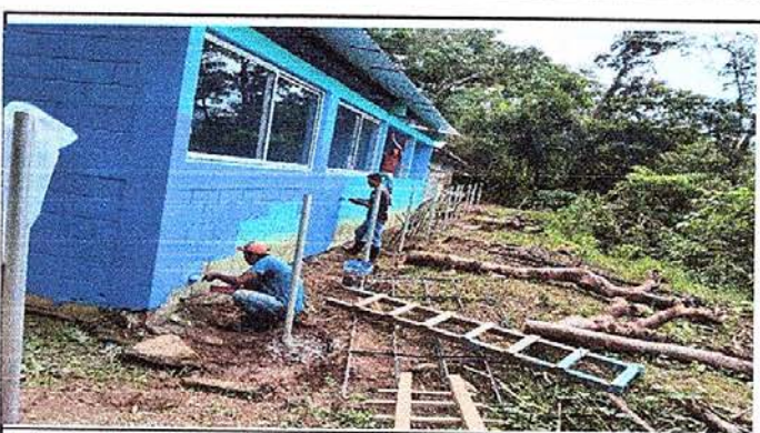
Foto 10: pintando muros exteriores
