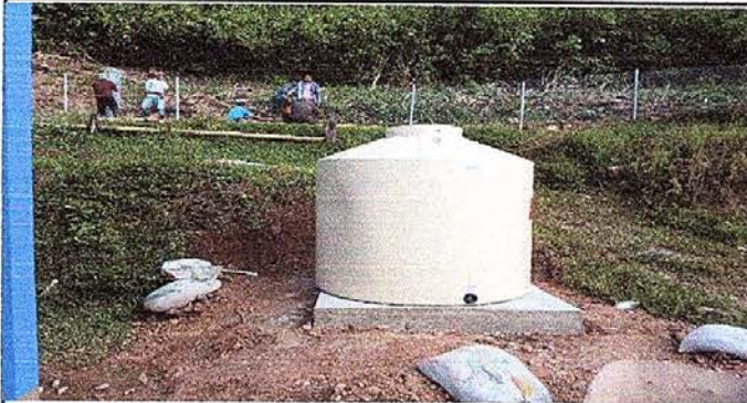
Foto 1: Se elabora la plancha de cemento y se sienta el deposito de agua.
