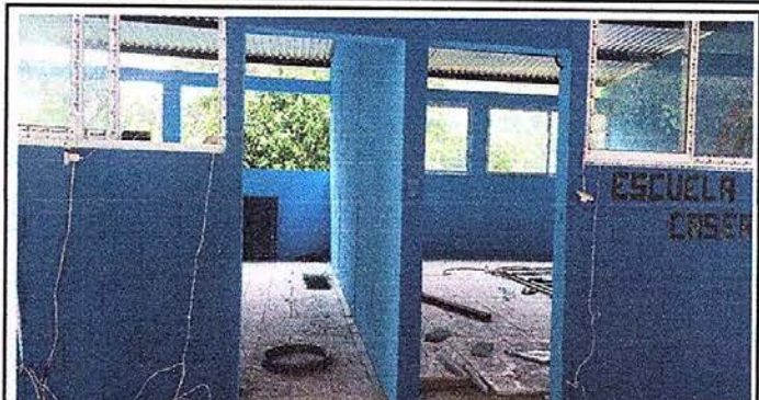
Foto 2: Se quitaron las puertas que ya estaban en malas condiciones
