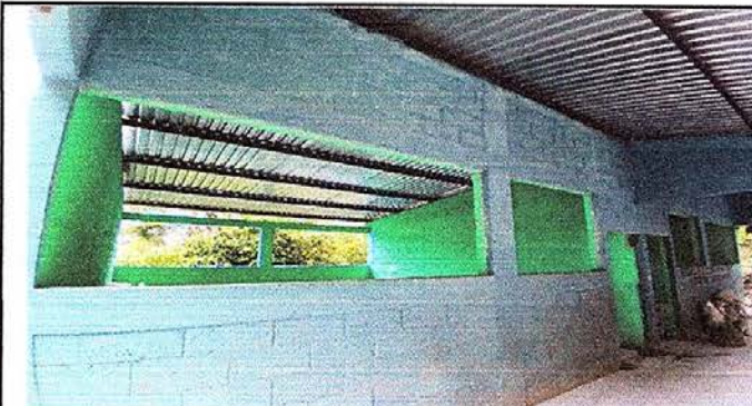
Foto 3: Se quitaron las ventanas del aula 1 que estaban en malas condiciones
