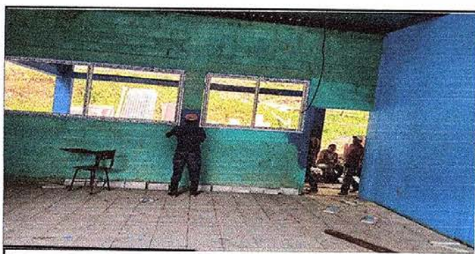
Foto 11: Pintando muros interiores
