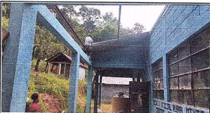
Foto 9: Inicio de sustitución de lámina en el techo
