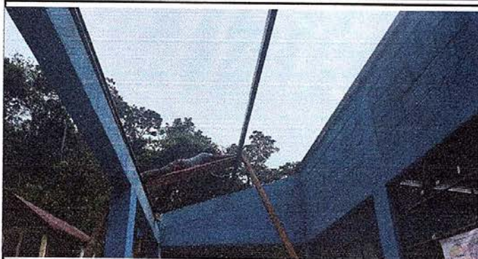
Foto 7: Inicio de mantenimiento a estructura de techo
