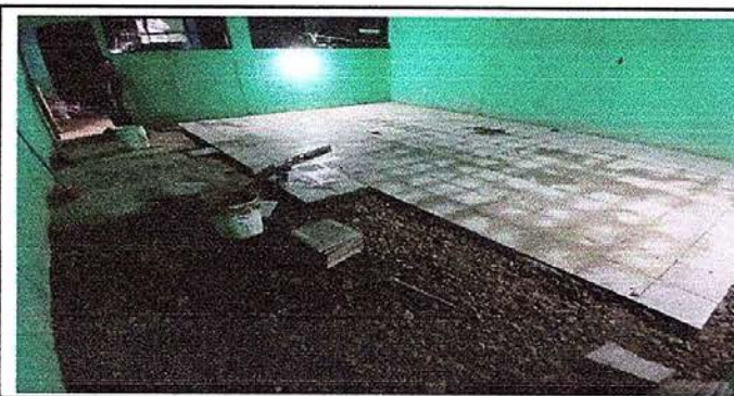
Foto 5: Se empieza a sustituir el piso en las aulas
