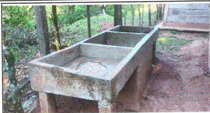
Foto 1: Depósito de agua en malas condiciones, el establecimiento no cuenta con agua potable
