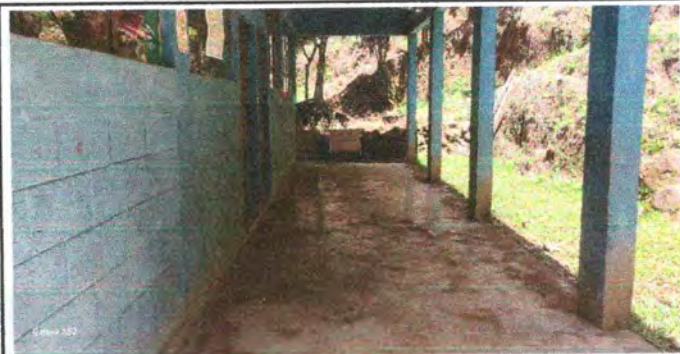
Foto 6: Piso del corredor de la escuela en malas condiciones necesita sustitución
