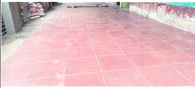
Foto 4: Sustitución de piso.
