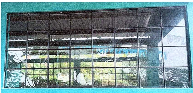
Foto 3: Sustitución de ventanas.
