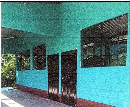
Foto 5: Pintura en muros exteriores e interiores.
