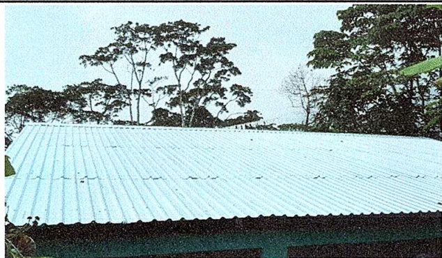
Foto 1: Sustitución de cubierta de lámina.
