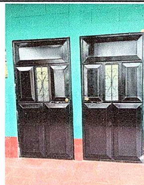
Foto 2: Sustitución de puertas de metal.
