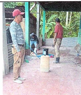
Foto 4: Sustitución de piso.
