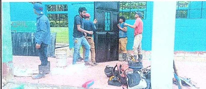
Foto 2: Sustitución de puertas de metal.
