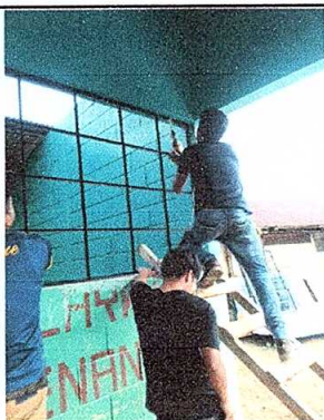
Foto 3: Sustitución de ventanas.
