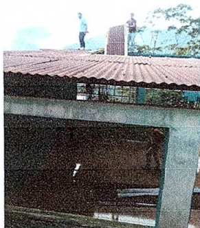
Foto 1: Sustitución de cubierta de lámina.
