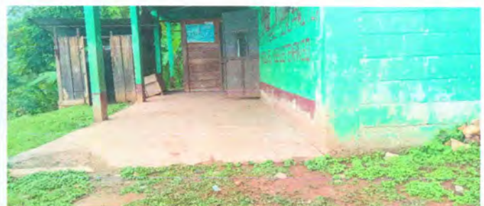
Foto 6: Reparación de piso de torta de concreto
