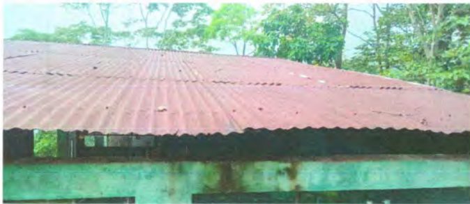
Foto 1: Sustitución de láminas, por lámina troquelada aluzinc calibre 26
