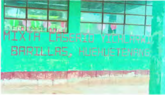
Foto 7: Pintura en muros exteriores e interiores.
