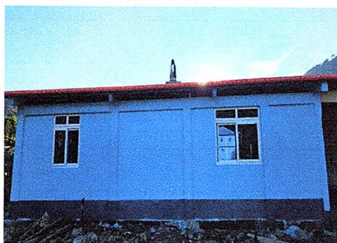
Foto 3: Bajadas de agua pluvial
