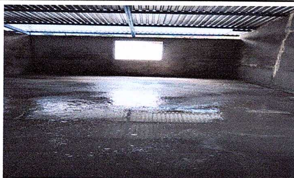
Foto 5: Piso de la cocina
