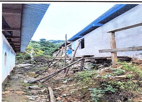
Foto 6: Reparación de muro de la cocina
