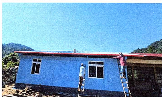
Foto 3: Bajadas de agua pluvial
