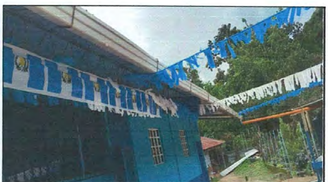
Foto 6: Sustrucion de canales de pvc
