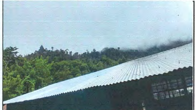
Foto 2: Sustrucción de techo
