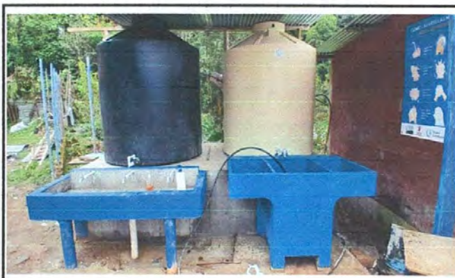
Foto 8: Sustitucion de depósito de agua
