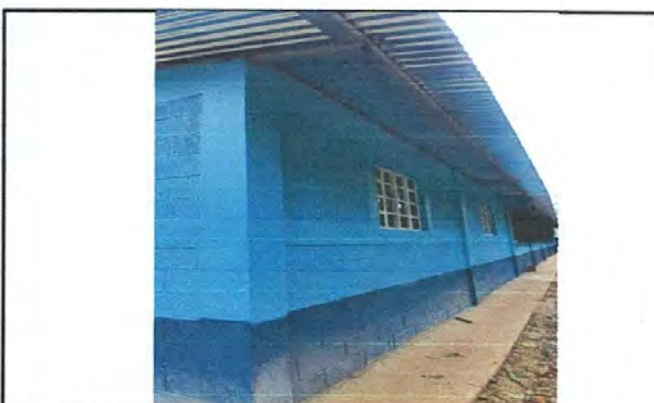
Foto 10: Mejoramiento de paredes
