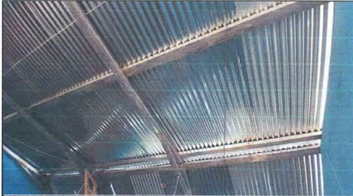
Foto 1: Sustrucción de estructura de soporte
