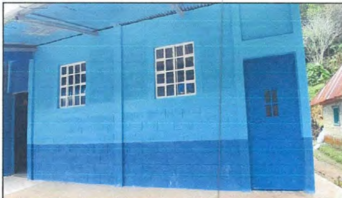
Foto 7: Pintura en muros exteriores e interiores
