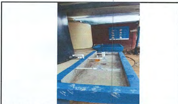
Foto 9: Sustitucion de pila
