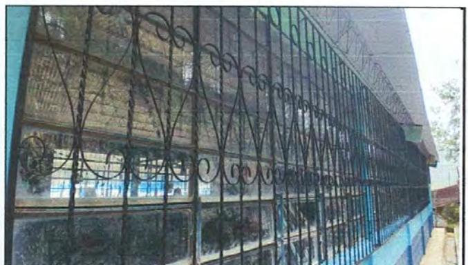
Foto 4: Mantenimiento de balcones de metal
