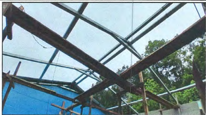
Foto 1: Sustrucción de estructura de soporte
