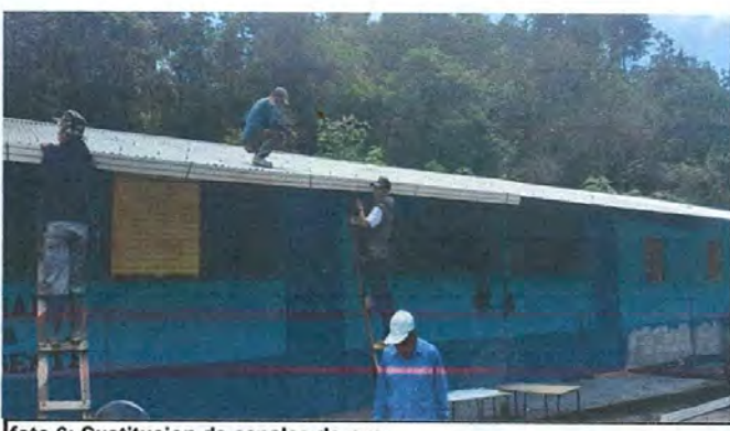
Foto 6: Sustrucción de canales de pvc
