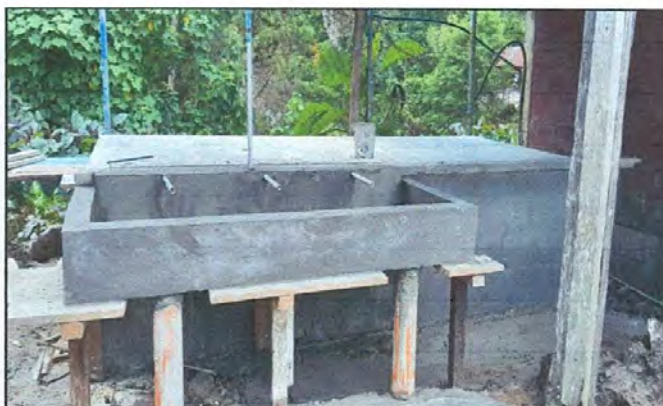
Foto 8: Sustitución de depósito de agua
