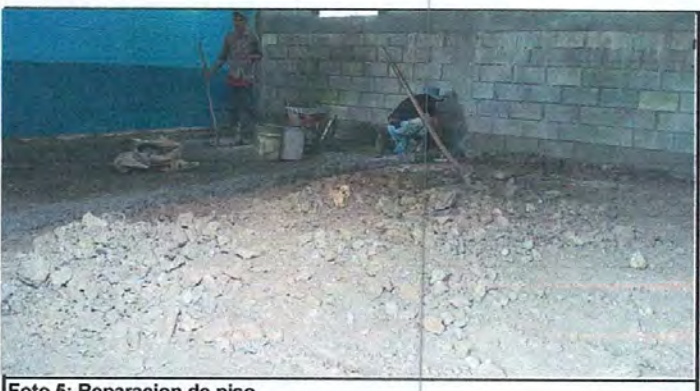
Foto 5: Reparación de piso
