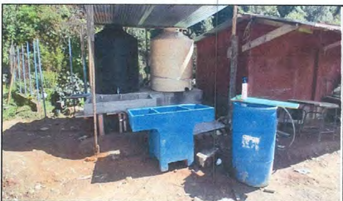
Foto 9: Sustitución de pila
