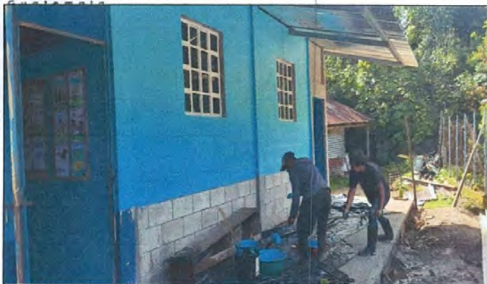
Foto 7: Pintura en muros exteriores e interiores
