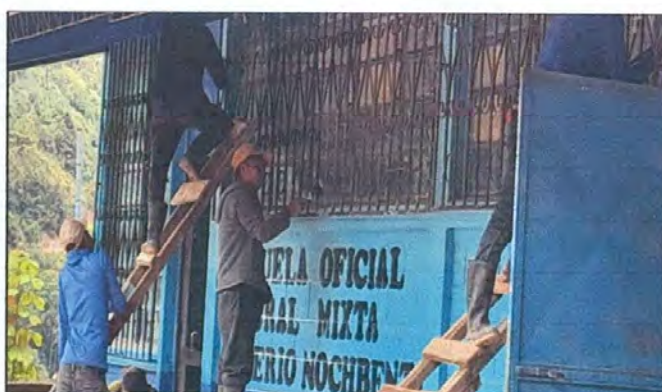
Foto 4: Mantenimiento de balcones de metal
