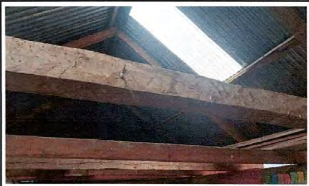
Foto 2: Sustitución de estructura de soporte
