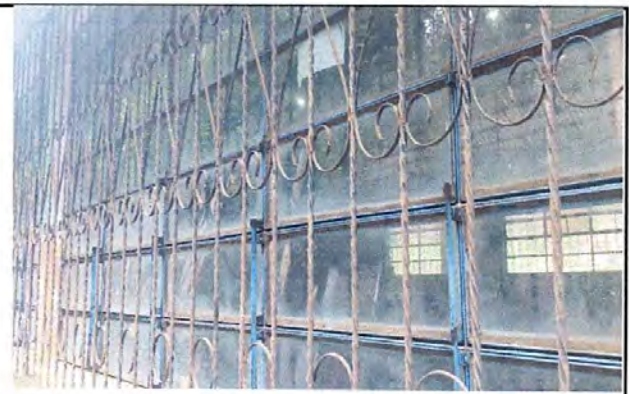
Foto 4: Mantenimiento de balcones de metal
