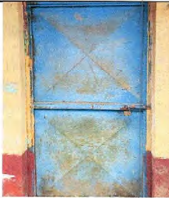
Foto 3: Sustitución de puerta
