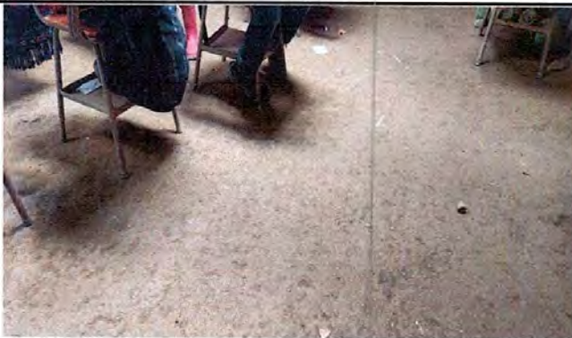
Foto 5: Reparacion de piso
