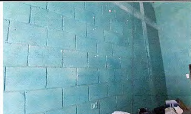
Foto 7: Pintura en muros exteriores e interiores
