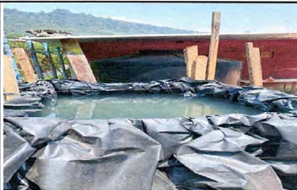
Foto 8: Sustitucion de depósito de agua
