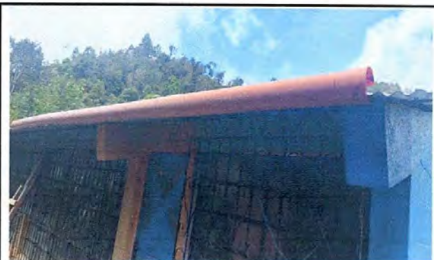
Foto 6: Sustitucion de canales de pvc
