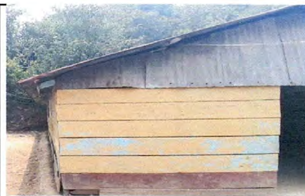
Foto 10: Mejoramiento de paredes
