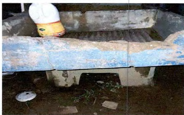
Foto 9: Sustitucion de pila
