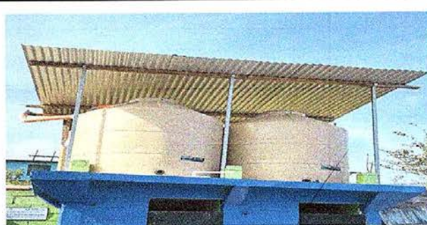
Foto No. 6 Reparación y mantenimiento de Cisternas/Depósitos de agua
