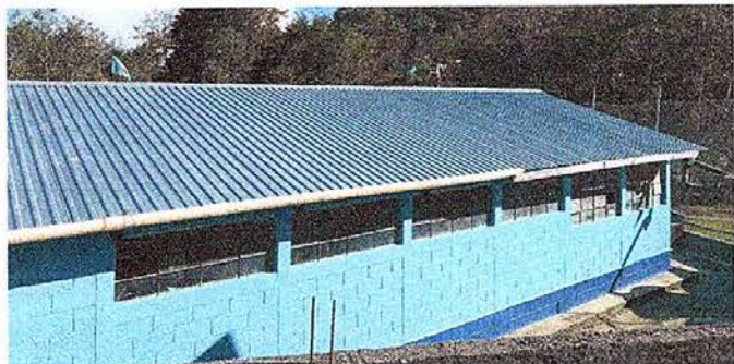
Foto No. 1 Sustitución de cubierta de lámina
