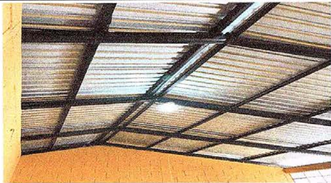
Foto No. 7 Reparación de sistema electrico
