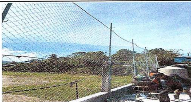
Foto No. 5 Muros perimetrales
