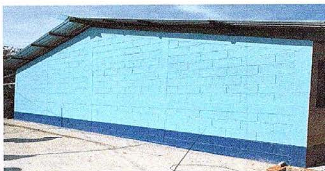
Foto No. 4 Pintura en muros en exteriores e interiores
