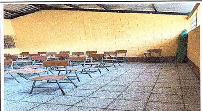
Foto No.3 Sustitución de piso
