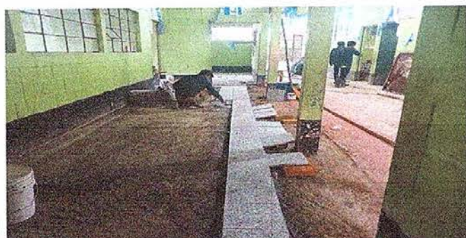
Foto No.3 Sustitución de piso
