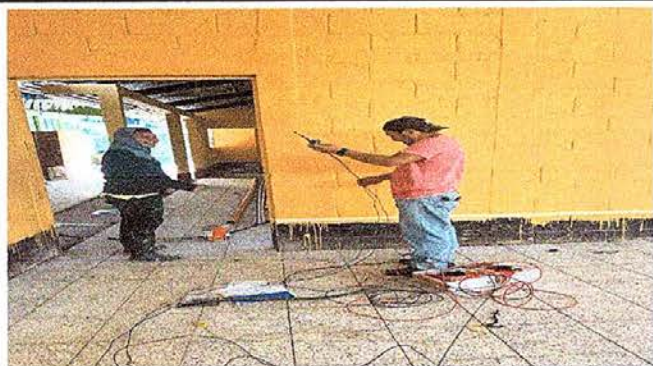
Foto No. 7 Reparación de sistema eléctrico
