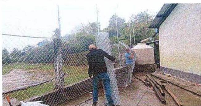
Foto No. 5 Muros perimetrales
