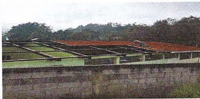
Foto No. 1 Sustitución de cubierta de lámina
