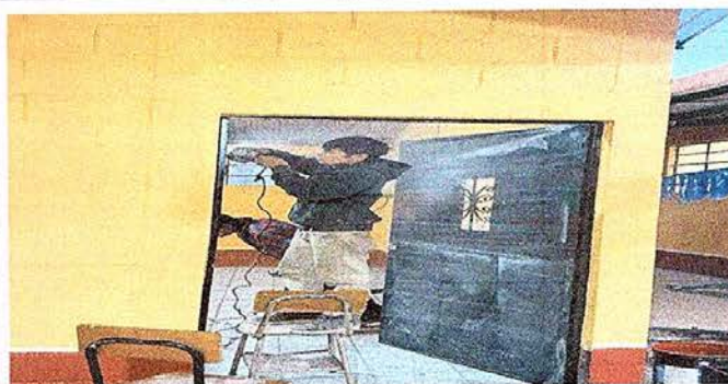
Foto No. 2 Sustitución de puertas
