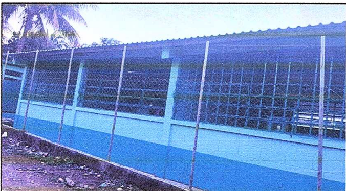
FOTO No. 3 Mantenimiento a muro perimetral
