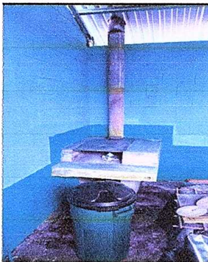
FOTO No. 1 sustitución de plancha y sustitución de pared de madera a bloch
