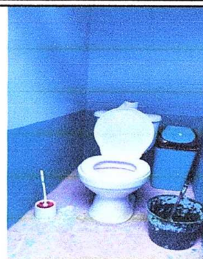
FOTO No. 2 sustitución de inodoro
