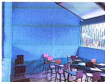
FOTO No. 1 sustitución de plancha y sustitución de pared de madera a bloch
