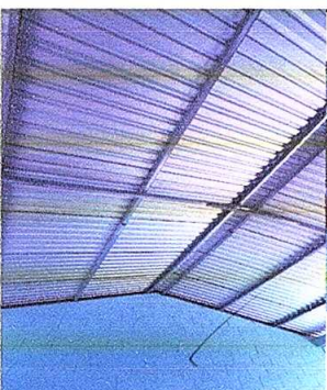
FOTO No. 5 Sustitución de costaneras y techo
