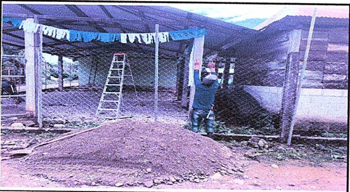
FOTO No. 3 Mantenimiento a muro perimetral
