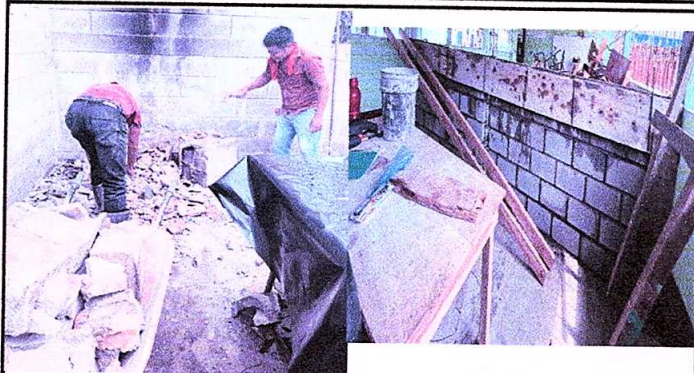
FOTO No. 1 sustitución de plancha y sustitución de pared de madera a bloch
