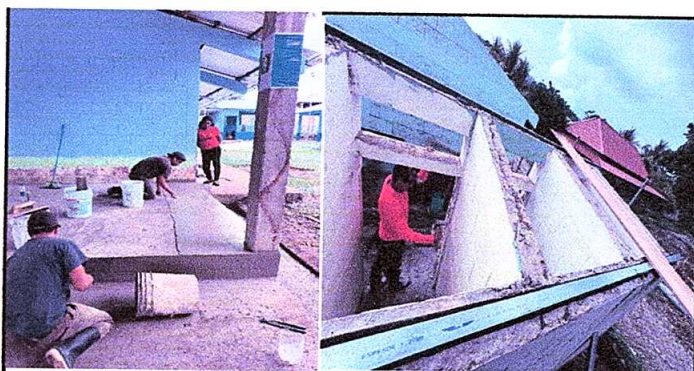
FOTO No. 6 Mantenimiento a piso y puertas
