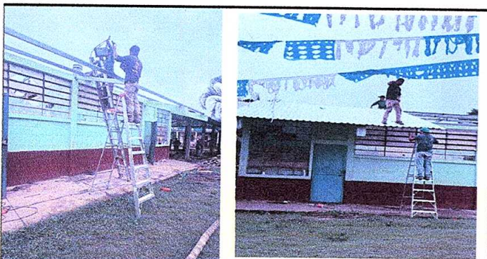
FOTO No. 5 Sustitución de costaneras y techo
