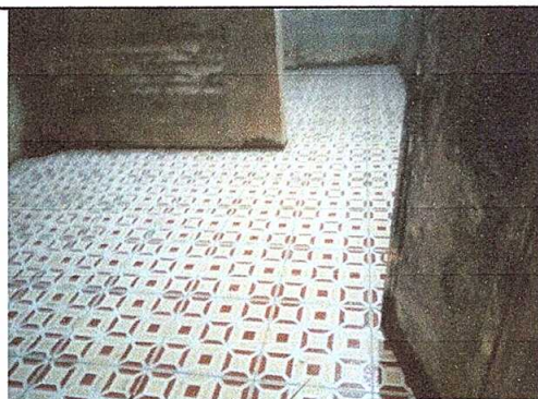
Foto 5: Reparación de piso.
