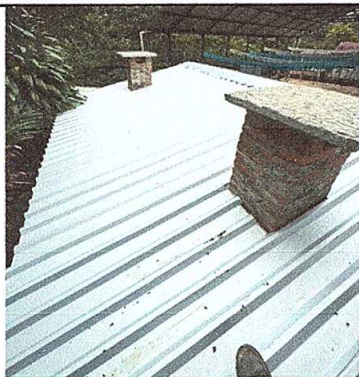
Foto 1: Sustrucción de cubierta de lámina.
