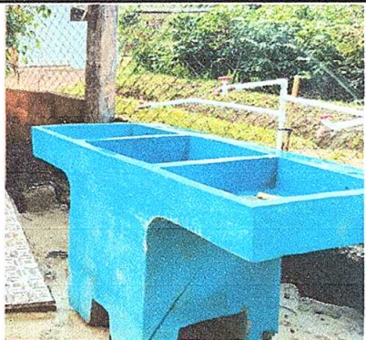
Foto 7: Sustitución de pila.
