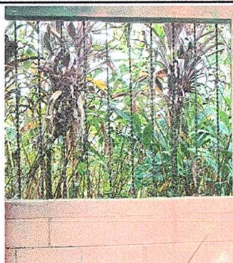
Foto 3: Sustitución de ventanas.
