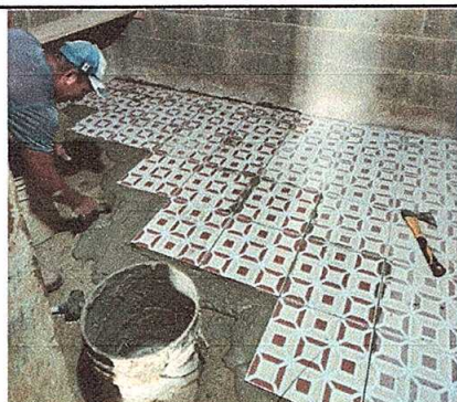
Foto 5: Reparación de piso.
