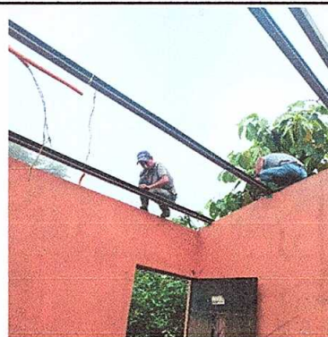
Foto 2: Sustitución de estructura de techo.
