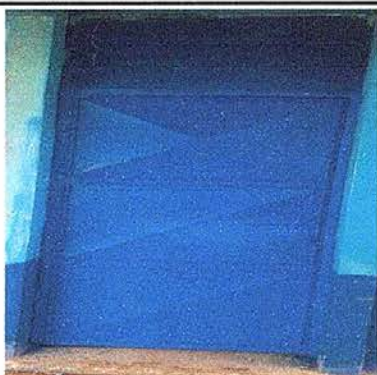
Foto No. 3: Sustitución de puertas
