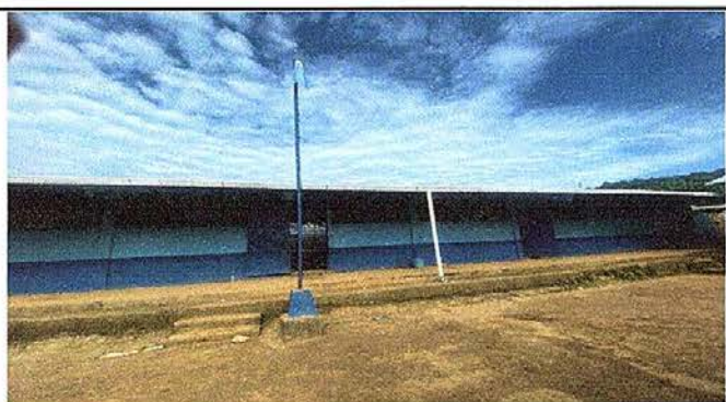
Foto No. 5: Sustitución canales de pvc
