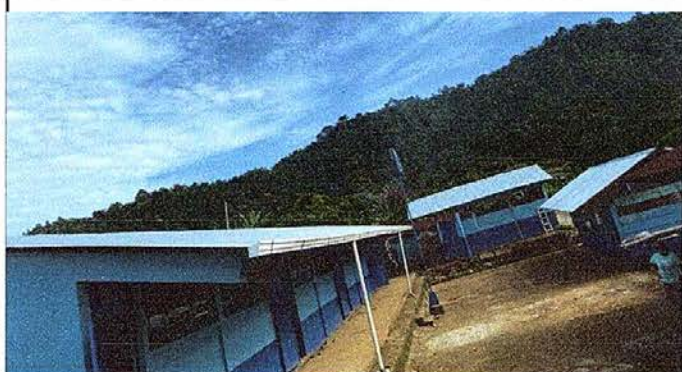
Foto No. 1: Sustitución de lámina por lámina toquelada de calibre 26, canales coloniales y bajante de agua fluvial
