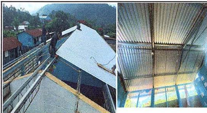
Foto No. 2: Sustitución de estructura de soporte de metal, y de madera por metal
