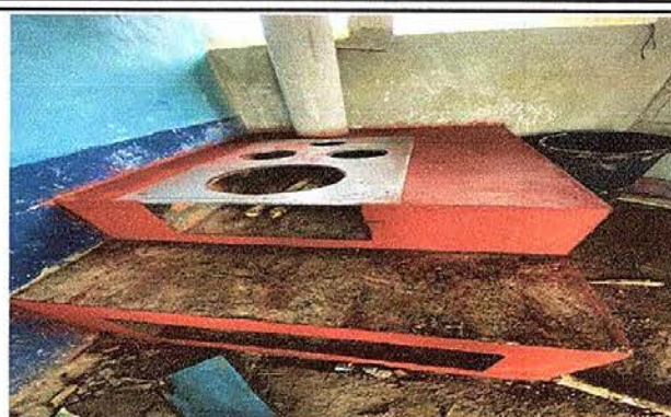
Foto No. 8: Sustitución de estufa rural (completa) incluye chimenea y plancha de metal
