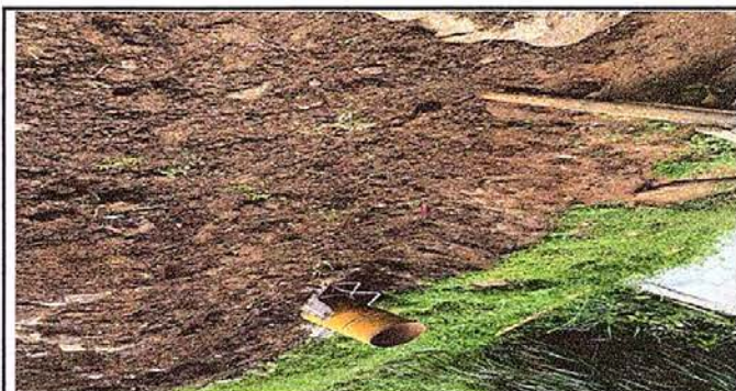
Foto No. 6: Sustitución de tubería PVC línea principal de aguas negras
