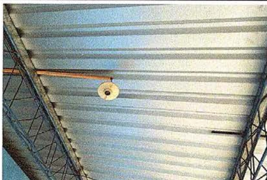
Foto No. 7: Reparación del sistema eléctrico.
