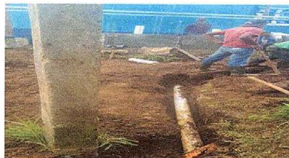
Foto No. 6: Sustitución de tubería PVC línea principal de aguas negras
