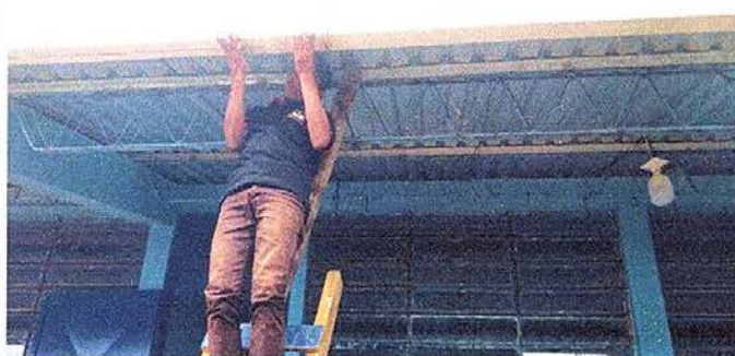
Foto No. 5: Sustitución canales de pvc
