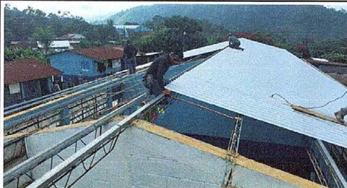
Foto No. 1: Sustitución de lámina por lámina toquelada de calibre 2026
