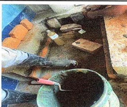
Foto No. 8: Sustitución de estufa rural (completa) incluye chimenea y plancha de metal
