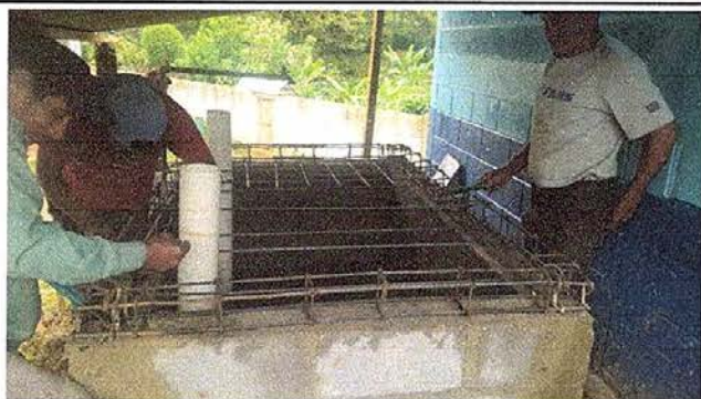
Foto No. 9: Sustitución de pila de cemento de dos lavadero
