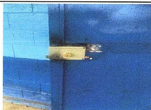
Foto No. 4: Sustitución de Chapas
