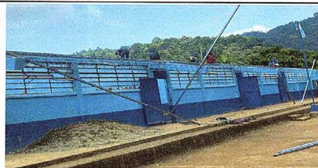
Foto No. 2: Sustitución de estructura de soporte de metal, por metal
