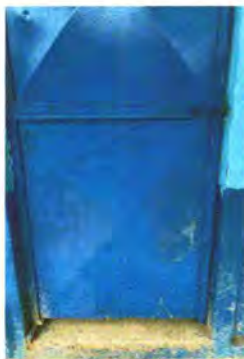
Foto No. 3: Sustrucción de puertas
