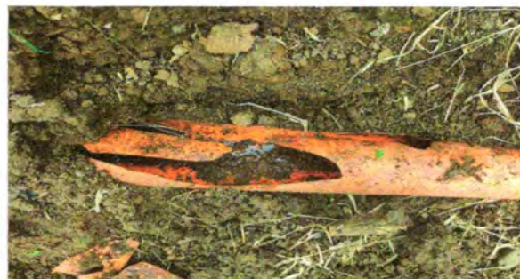
Foto No. 6: Sustrucción de tubería PVC línea principal de aguas negras
