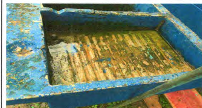
Foto No. 9: Sustitución de pila de cemento de dos lavadero
