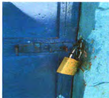
Foto No. 4: Sustrucción de Chapas
