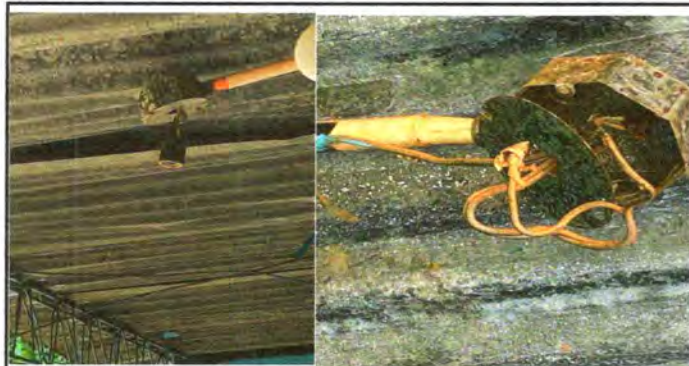
Foto No. 7: Reparación del sistema eléctrico.
