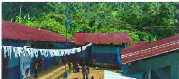
Foto No. 1: Sustrucción de lámina por lámina toquelada de calibre 2026
