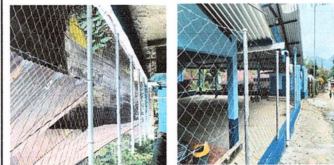
Foto No. 3: Finalización de la reparación del muro perimetral.
