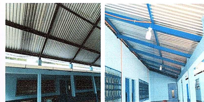
Foto No. 4: Finalización de la aplicación de pintura en muros exteriores e interiores.
