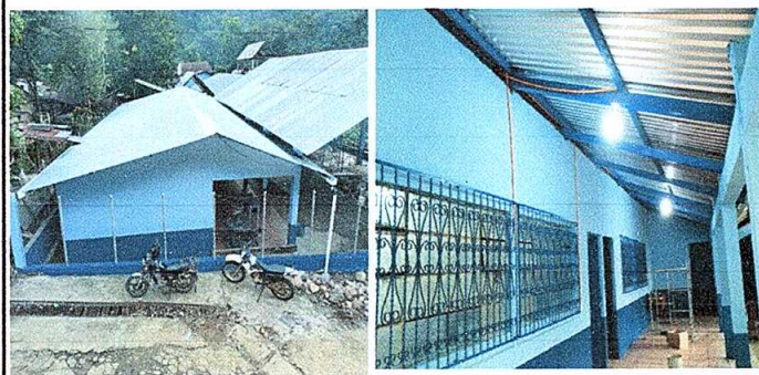
Foto No. 1 Finalización de la sustitución de lámina por lámina troquelada, sustitución de capote de lámina por lámina troquelada y sustitución de estructura de soporte de madera por metal.
