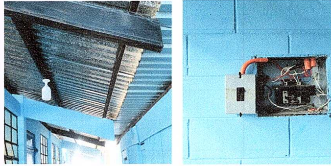
Foto No. 2: Finalización de la sustitución y reparación eléctrica general.
