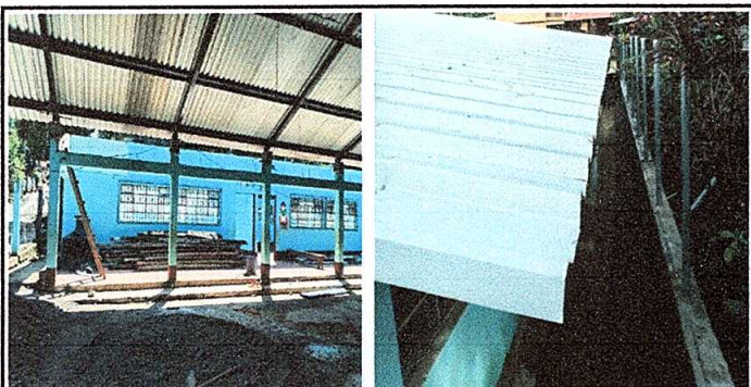
Foto No. 5: En proceso de la sustitución de canal de PVC.
