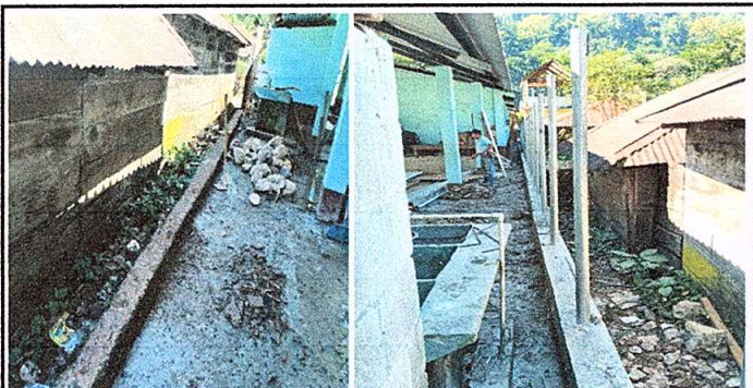
Foto No. 3: En proceso de la reparación del muro perimetral.
