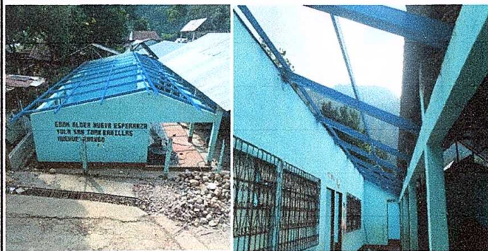
Foto No. 1 En proceso de la sustitución de lámina por lámina troquelada, sustitución de capote de lámina para lámina troquelada y sustitución de estructura de soporte de madera por metal.
