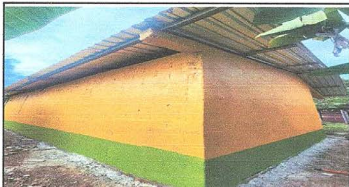
Foto 3: mejoramiento de pared de madera por block de cocina
