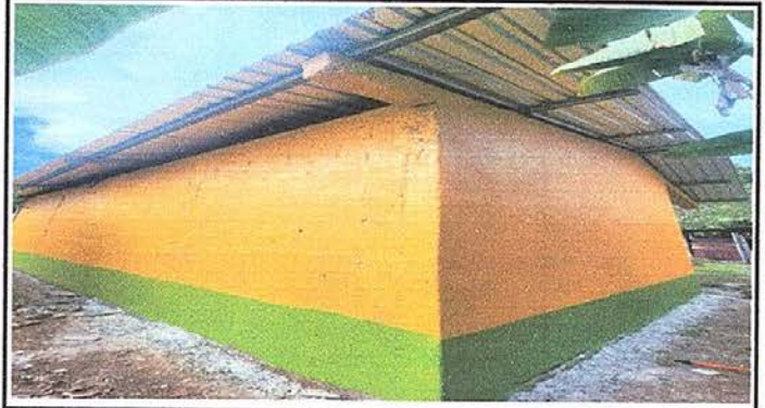
Foto 8: reparación de pared con solera y columnas
