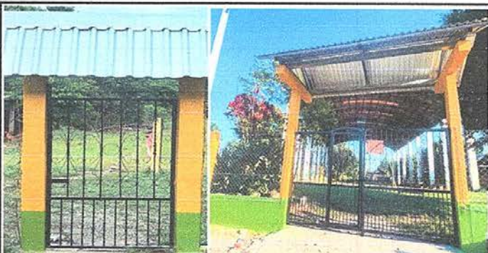
Foto 6: Sustitución de portón de metal por metal
