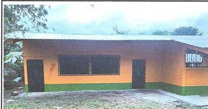
Foto 5: Sustitución de puertas de madera por metal y sustitución de ventanas de madera por balcones de metal.
