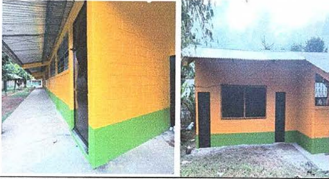
Foto 7: Pintura en muros exteriores e interiores
