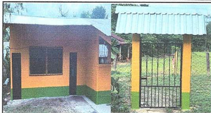
Foto 1: sustitución de lámina por lámina troquelada
