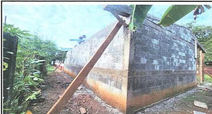
Foto 8: reparación de pared con solera y columnas
