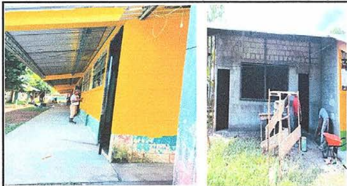
Foto 7: Pintura en muros exteriores e interiores
