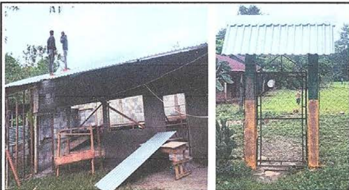
Foto 1: sustitución de lámina por lámina troquelada
